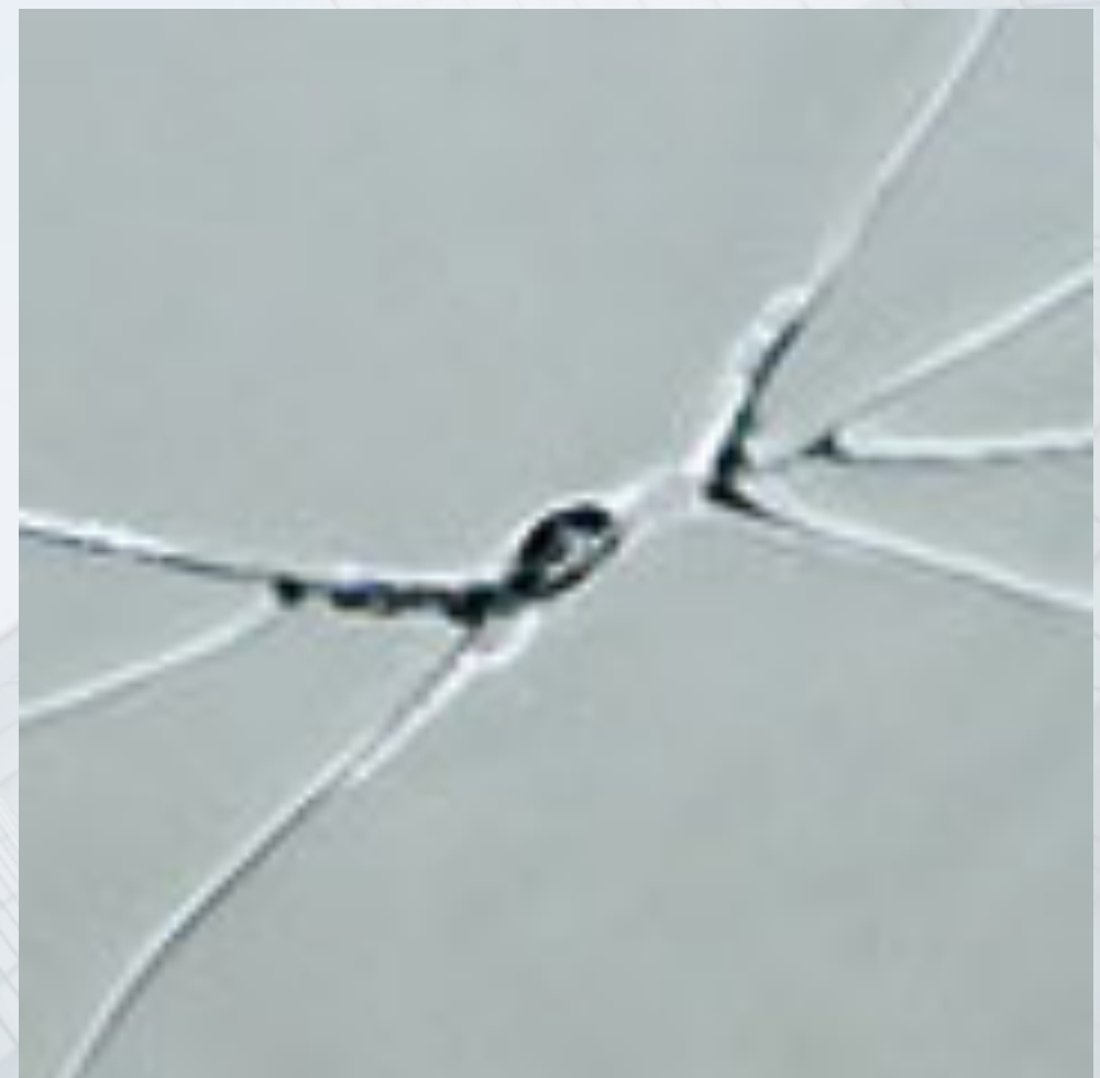
熱處理增強玻璃破裂時為大片碎片
